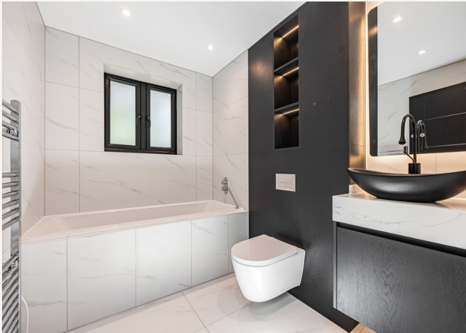
En suite, wall-hung sanitaryware
